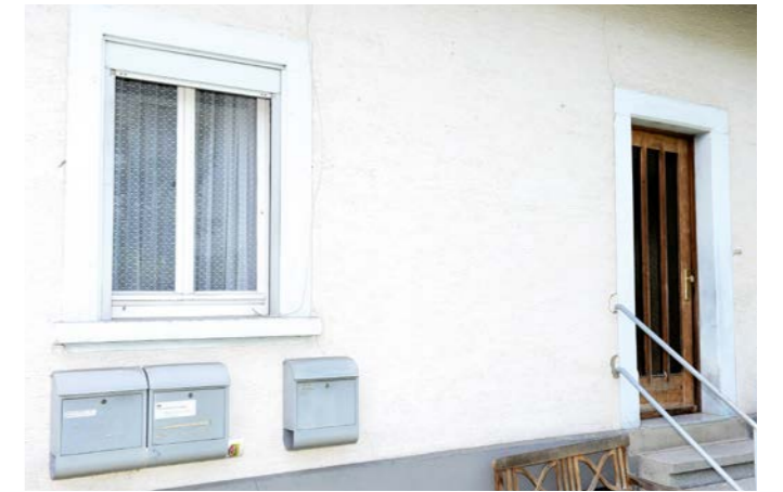
Ganzheitlich sanieren: Wird die Fassade erneuert, ...
